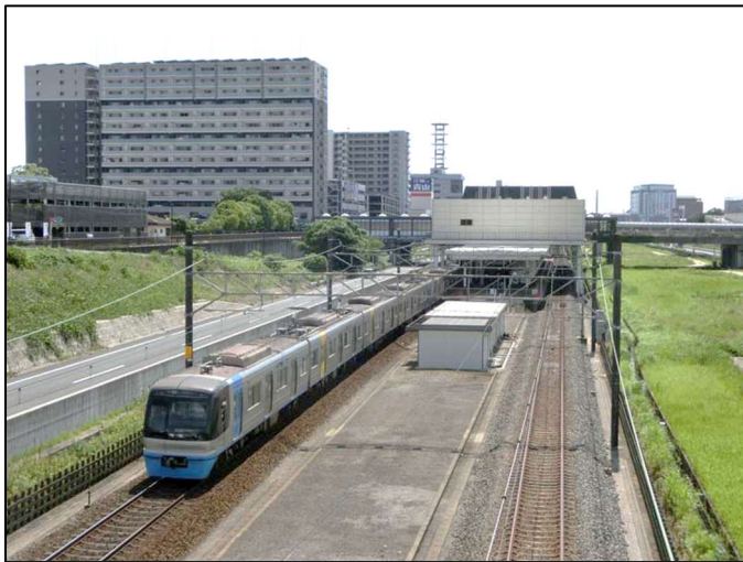
「北総線千葉ニュータウン駅付近」
